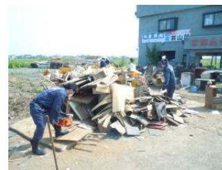
外では撤去材の解体分別
