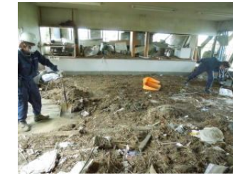
堆積した汚泥も除去
