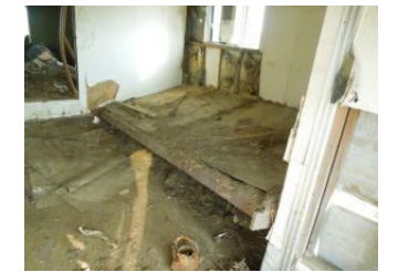
汚泥も撤去しました
