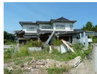
津波で破壊された家
